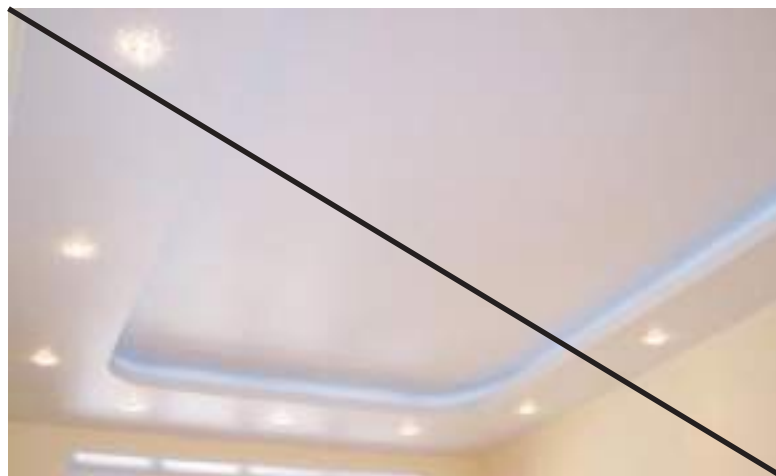
Плохо Многоуровневые гипсокартонные конструкции
