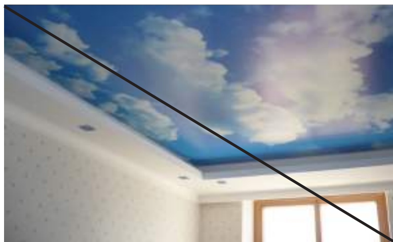
Плохо Натяжные потолки. Потолки с рисунками
